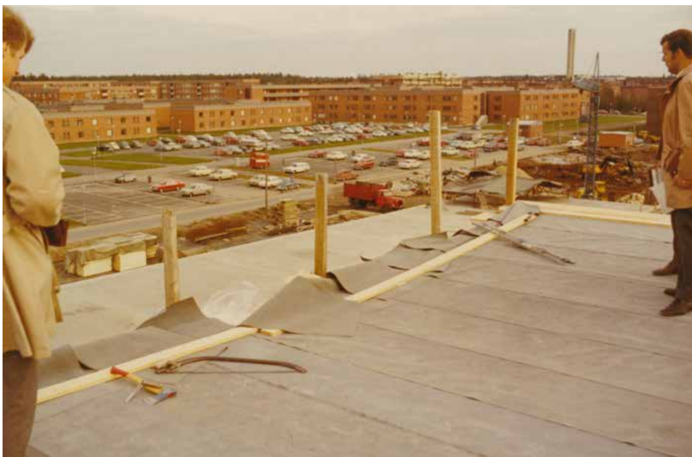
Foto: Ålindh, Sv Byggnadsarbetareförbundet avd 37 Umeå – Folkrelsearkivet i Västerbotten
